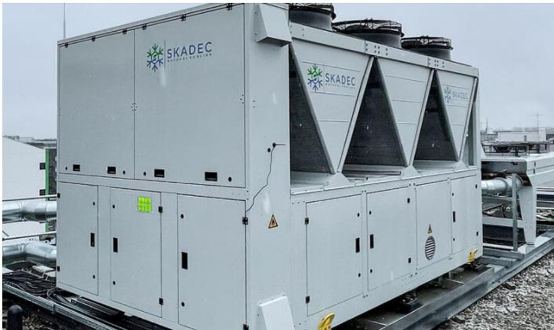
Abb.6: Ein Skadec R290 Kaltwassersatz [5]
